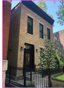
1328 N. WICKER PARK AVE.
