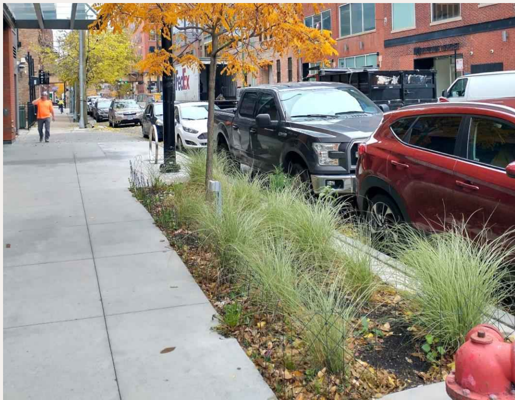
Jardinera de aguas pluviales
