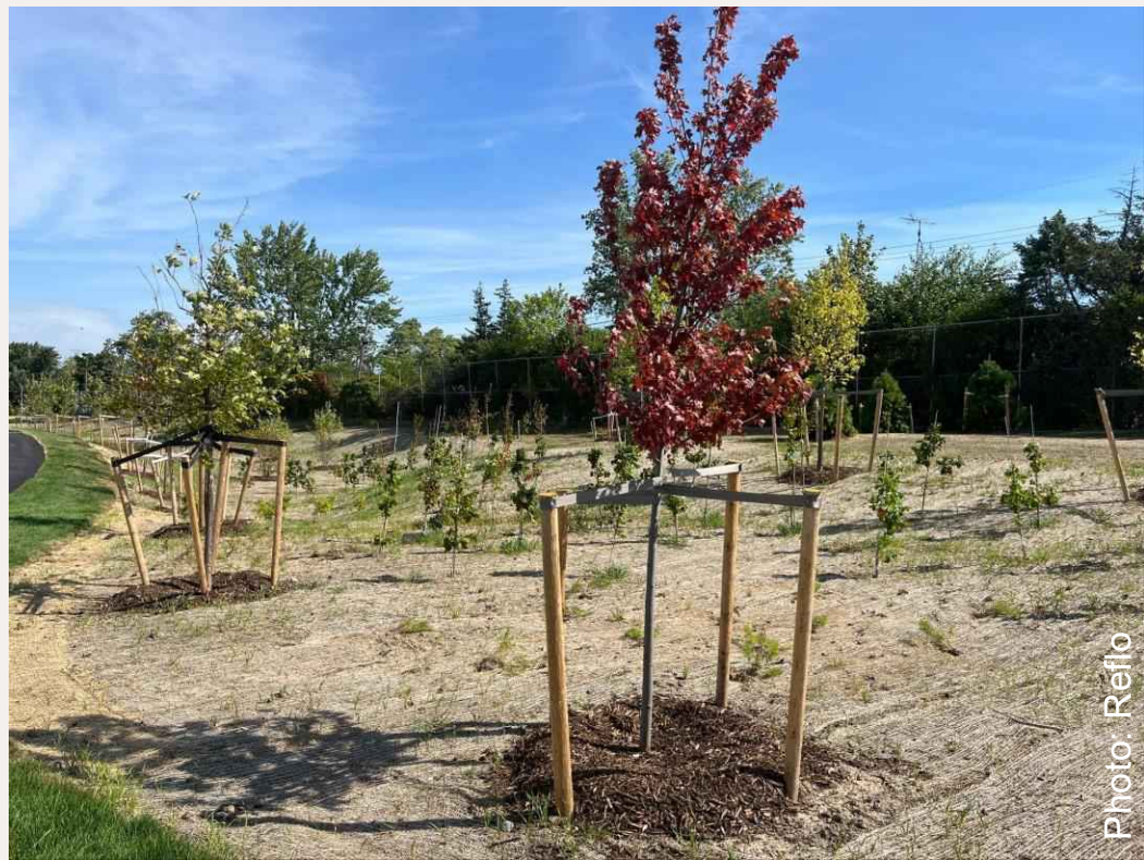
Árboles de aguas pluviales
