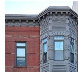
Figure 27. Metal cladding
