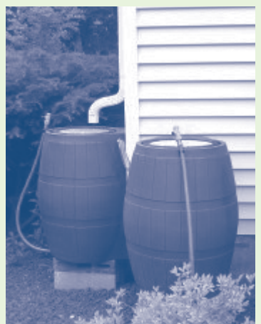
Un depósito para lluvia sobre bloques de cemento que está conectado al tubo de bajada.
