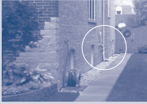
Este es un ejemplo de un sitio en el que el tubo de bajada no debe ser desconectado. El agua hará que el camino sea resbaloso en el invierno.
